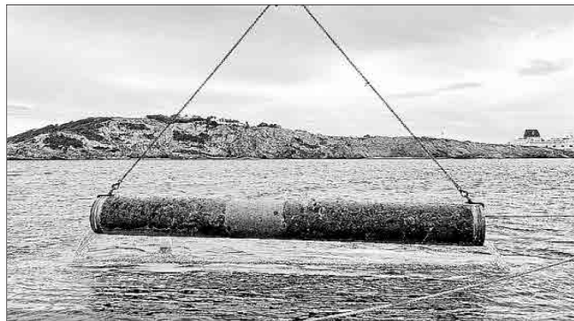
Retirada del emisario de Talamanca. Foto: GOIB
